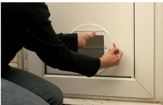
Use o adaptador de montagem da SureFlap como guia para marcar a circunferência do adaptador circular.
