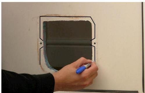
Marque a linha com um marcador de tinta permanente e faça o recorte ao longo das linhas (deixando os orifícios para os parafusos como se indica de seguida).
