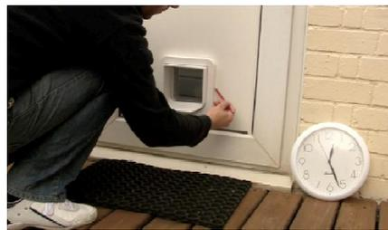
Terá que recortar uma abertura maior na porta, deixando um espaço vazio de 2-3 cm entre o túnel da SureFlap e o metal na porta.
