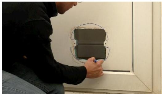
Marque um círculo de aproximadamente 2 cm na parte interior da linha marcada para recortar a abertura e deixe os entalhes para os parafusos como estavam.
